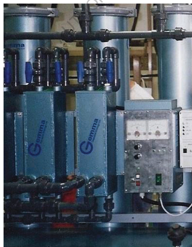
Рисунок 4. Интегративное сочетание в одной системе колонн ионной обменной обработки с автоматическими самоочищающимися механическими фильтрами
